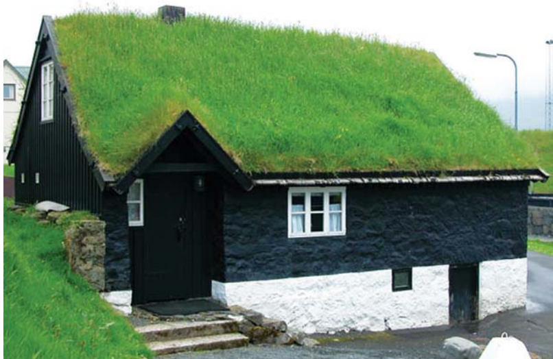
Fot. 1. Przykład dachu ekstensywnego [11]
